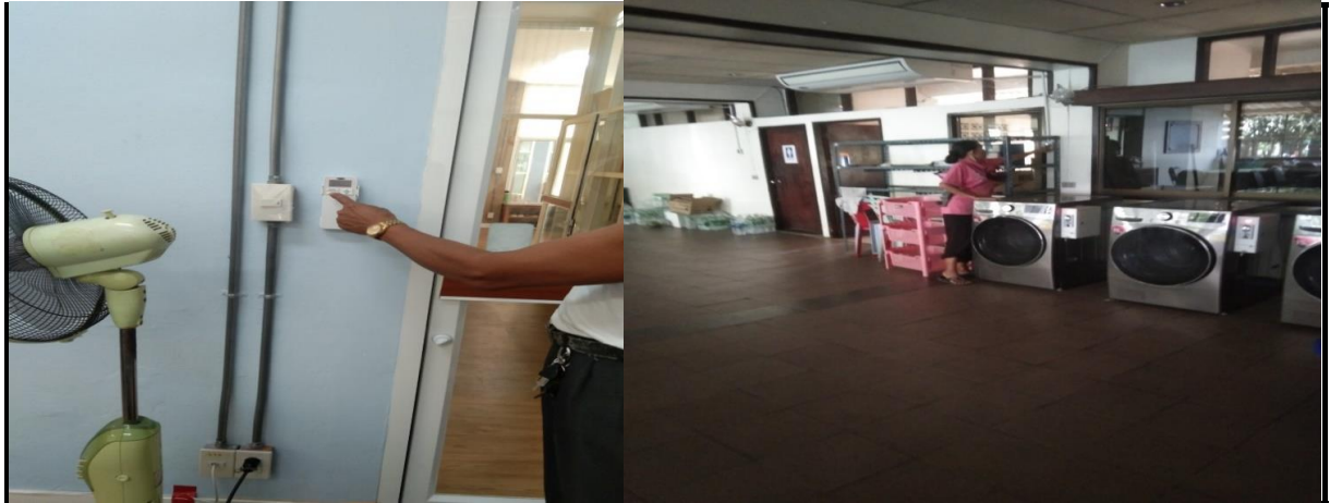
รูปที่ 6-3 หลังดำเนินการปรับปรุง
