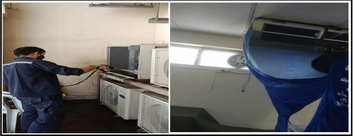
รูปที่ 5-2 ภาพก่อนดำเนินการปรับปรุง
