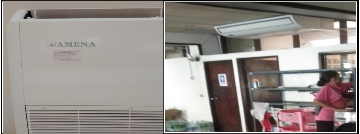
รูปที่ 6-1 หลังดำเนินการปรับปรุง
